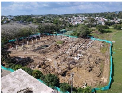
Fotografía 20. Vista General Polideportivo
