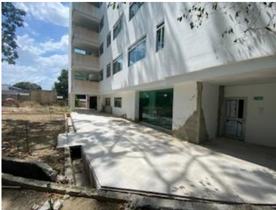
Fotografía 30. Construcción de andenes y cunetas
