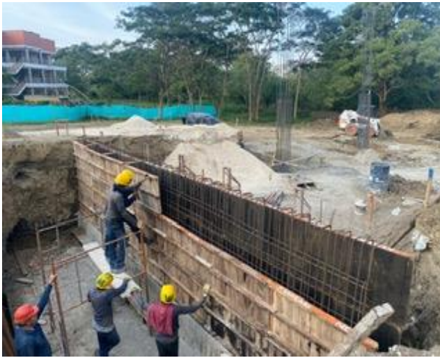
Fotografía 31. Construcción muro de contención
