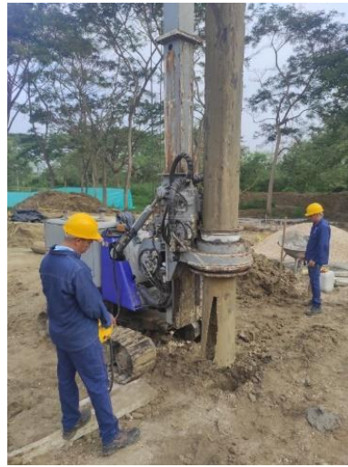
Fotografía 32. Construcción de pilotes
