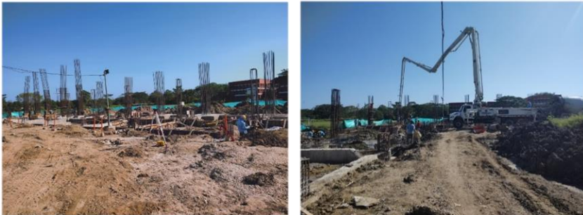
Fotografía 19. Inicio Construcción de columnas Polideportivo.
