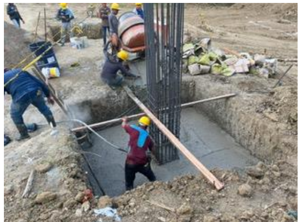
Fotografía 34. Construcción de zapatas
